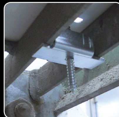
2. Tillhörande brickor placeras enligt bild under trappsteget så att de ligger mot trappans tvärgående gallerplåt.
