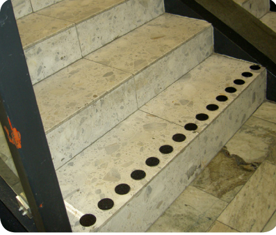
Översta och nedersta trappsteget i varje trapplopp ska kontrastmarkeras.
