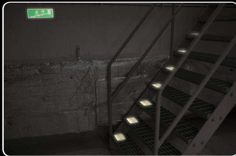
Bilderna visar exempel på gallerdurksmarkering både i dagsljus och i mörker.
