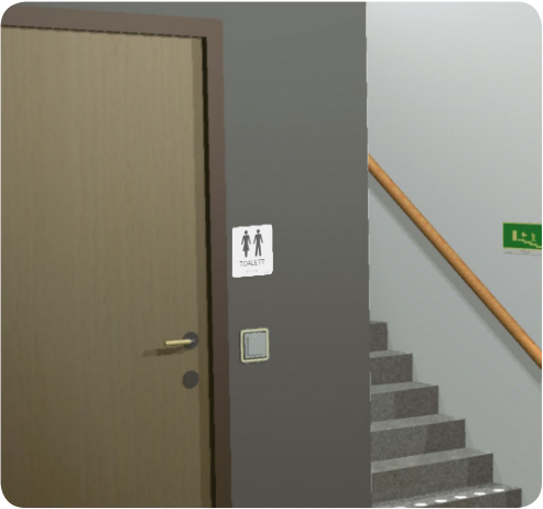
Taktila skyltar vid dörrar ska sättas upp på väggen vid dörrens handtagssida och inte på själva dörren, för att undvika sammanstötning med dörren om den öppnas när man läser skylten taktilt.
