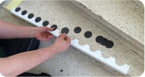
Montering av kontrastmarkering 339450 med hjälp av monteringsmall 338162
