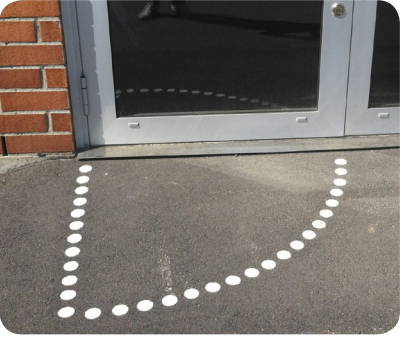
Markering av svepyta på golvet eller på marken visar att dörren öppnas automatiskt vilket mins- kar risken för att få dörren på sig.
