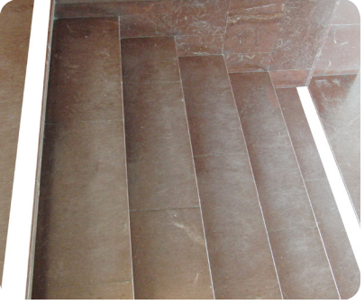
Översta och nedersta trappsteget i varje trapplopp ska kontrastmarkeras.
