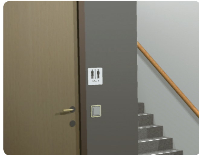
Taktile skilt på dørene skal installeres på veggen på dørhåndtakssiden og ikke på døren selv, for å unngå kollisjon med døren om den åpnes når du leser tegnet taktisk.
