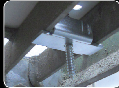
2. Tilhørende brikker monteres som vist på foto under trappesteget slik at de ligger mot trappens tversgående gitterplate.
