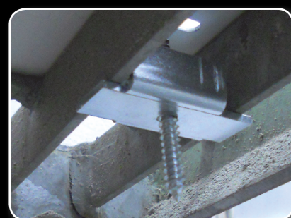
2. Tilhørende brikker monteres som vist på foto under trappesteg slik at de ligger mot trappens tversgående gitterplate.
